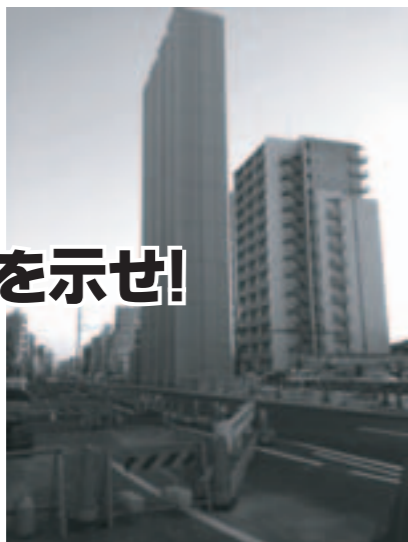
環状6号線要町排気塔
